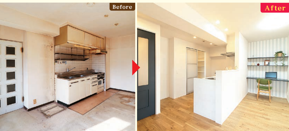
②キッチンは向きを逆にして対面式に変更。全面カーペットだった床はフローリングにし、ダイニング奥には便利なワークスペースを増設。新しいドアの色がアクセントとなり空間をスタイリッシュな印象に。
